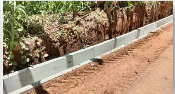
මොනරාගල දිස්ත්‍රික්කයේ බඩල්කුඹුර ප්‍රාදේශීය සභා බල ප්‍රදේශයේ වෙලන්හින්න - කිරිගල්පොත්ත මාර්ගයේ U වර්ගයේ පැති කාණු ඉදිකිරීම
